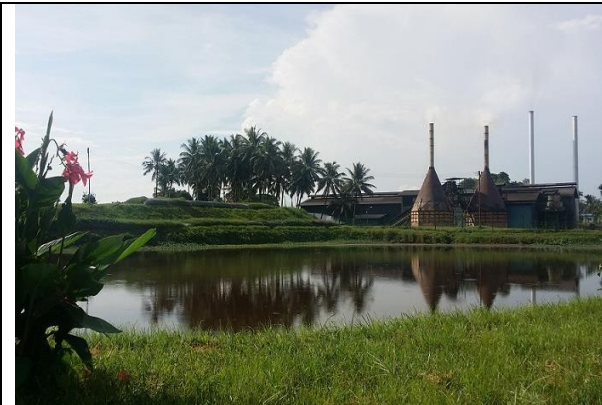
Unico POM – Effluent ponds
